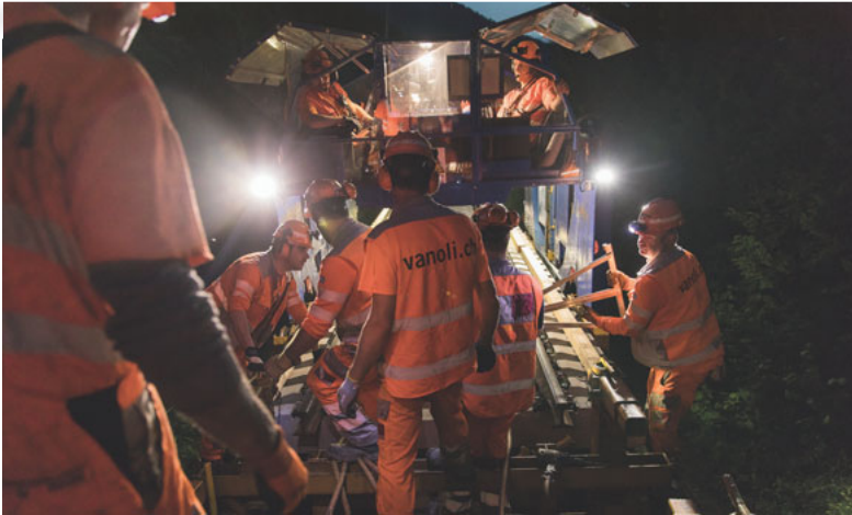
Baustelle Därligen-Leissigen. Vom 30. April bis Mitte Juni 2018 wechselten die Gleisbauer in 30 Nachtschichten die alten Holzschwellen mit neuen Betonschwellen aus.
