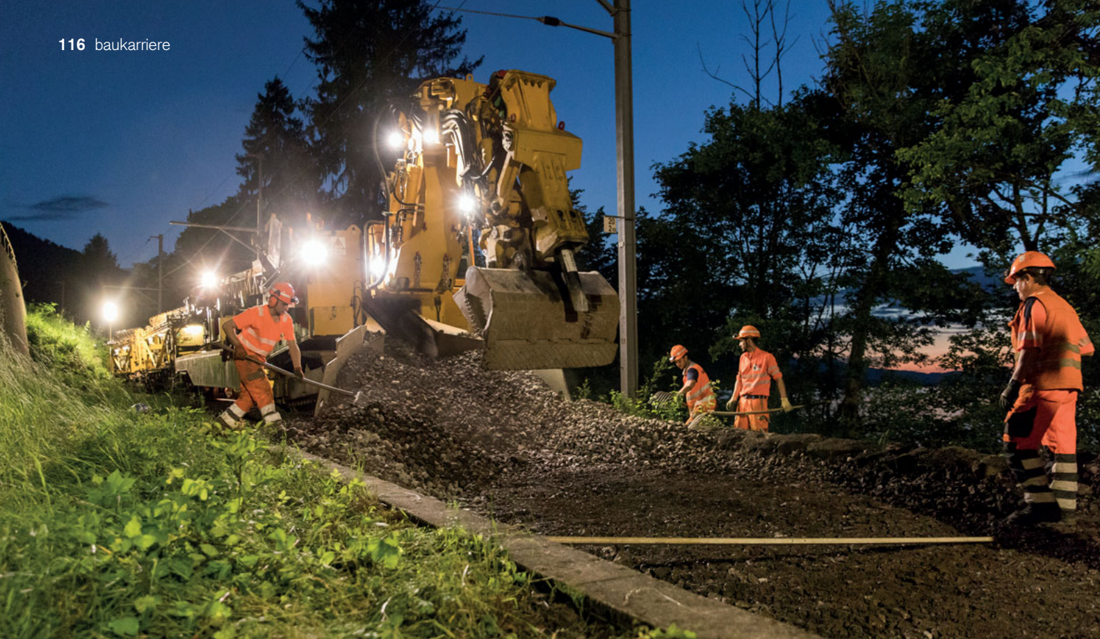
Mit dem «Puscal T» wird der neue Schotter aufgeschüttet.
