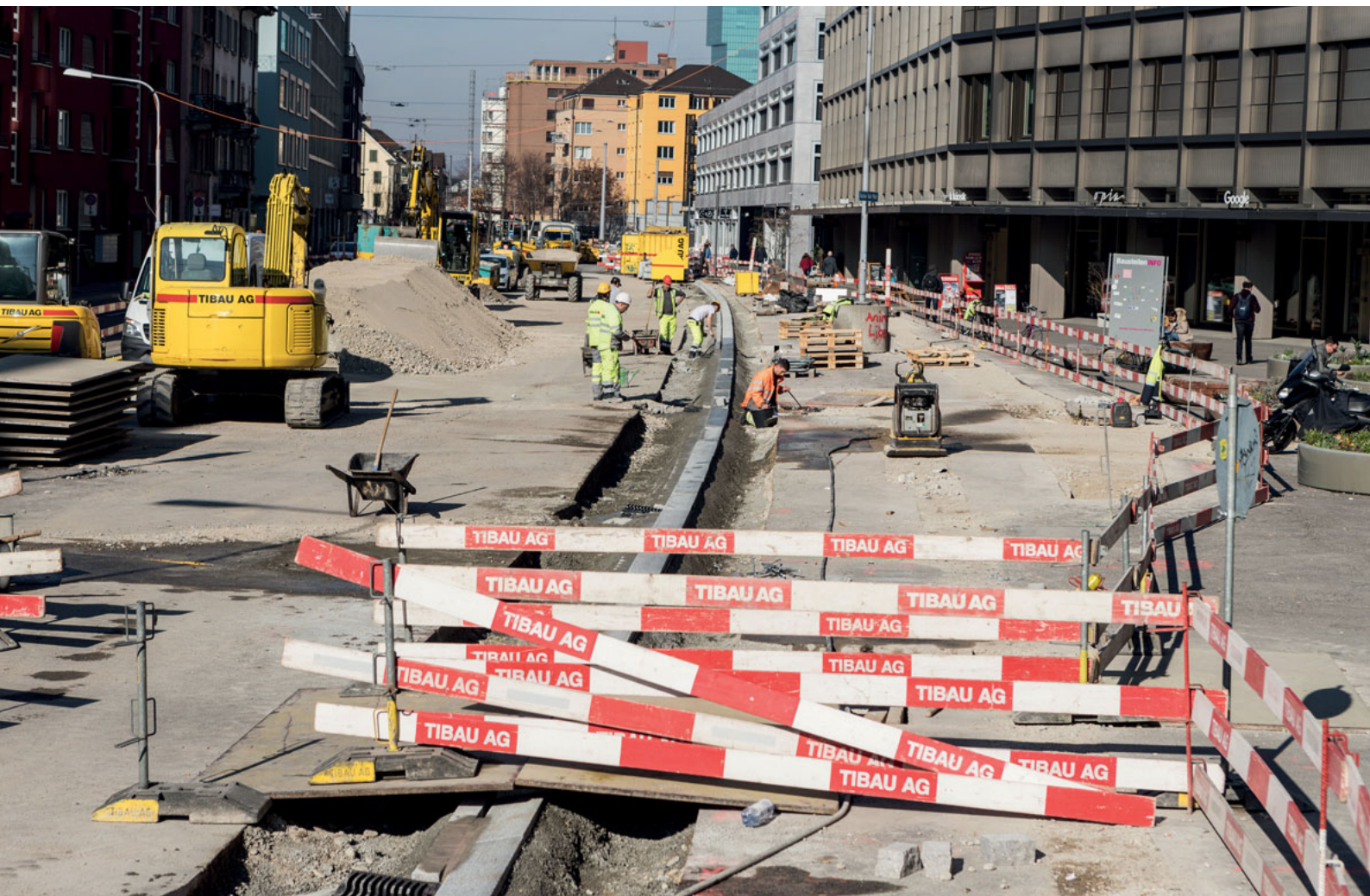
Baustelle Langstrasse-Lagerstrasse: Bis Juli 2019 müssen Bauarbeiter, Autofahrer, Radfahrer und Partygänger aneinander vorbeikommen.
