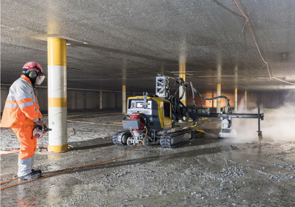
Mit dem Höchstwasserdruckverfahren ist die Hydrojet AG ein Pionier im Betonabtrag, kann aber auch in industriellen Bereichen punkten.
