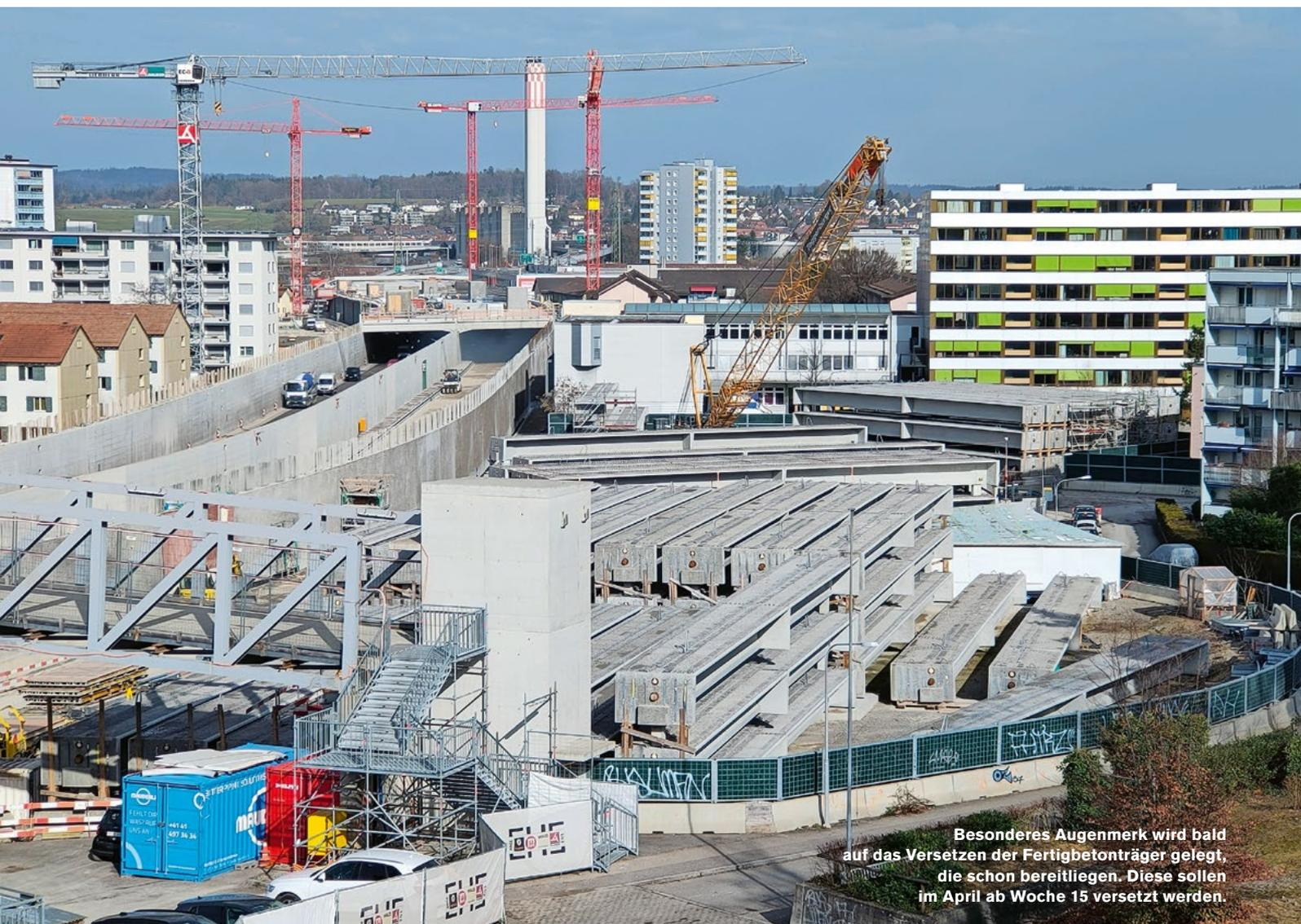
Besonderes Augenmerk wird bald auf das Versetzen der Fertigbetonträger gelegt, die schon bereitliegen. Diese sollen im April ab Woche 15 versetzt werden.
